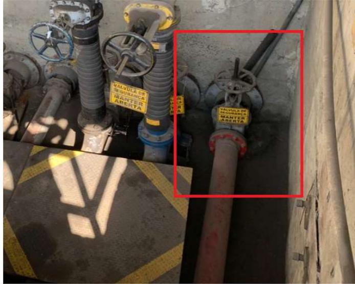
Figura 6 - Imagem da tubulação de água de combate a incêndio do cais, que passa internamente ao RDJ06
